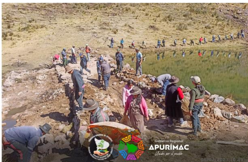
Construcción de qochas artesanales (recarga hídrica)
