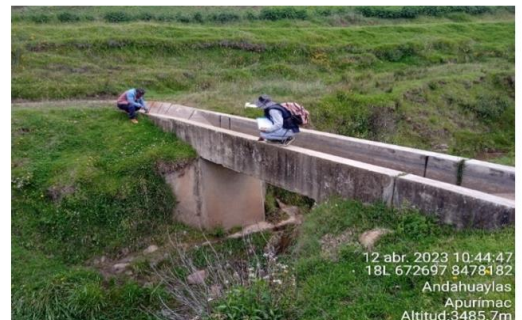
Inventariado de infraestructura hidráulica de riego
