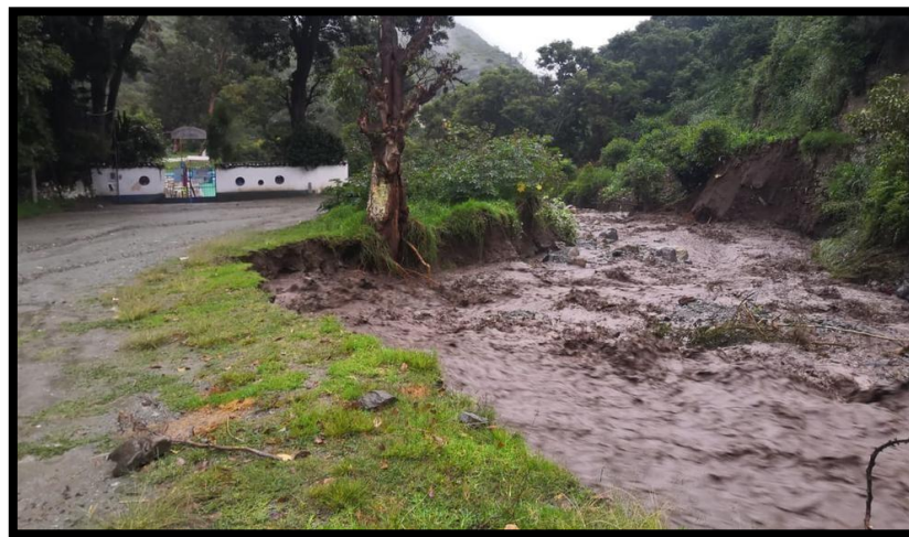
FIGURA 45. CRECIDA DEL CAUDAL DEL RIO COLCAQUI, SECTOR MARIÑO - ABANCAY
