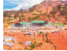
MEJORAMIENTO DE SERVICIOS EDUCATIVOS DE LA INSTITUCION EDUCATIVA INTEGRADA ERNESTO GUEVARA DE LA SERNA DE LA COMUNIDAD DE LAMAY, DISTRITO DE SANTA MARIA DE CHICMO
