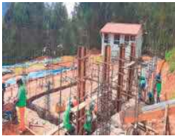
IEP PATAHUASI DEL DISTRITO DE HAQUIRA
