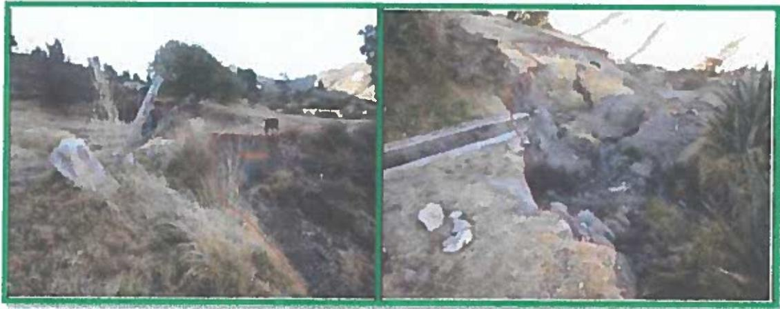
*Imagen 06 - Canal de riego destruido centro poblado Cconchayoc Haqira – deslizamiento*
