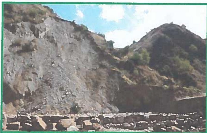
*Imagen 04 - Derrumbe que originó la ruptura de la base de la carretera Cusco - Abancay*
